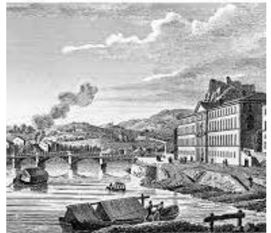
Vue du Port-Neuf sur le Rhône, à Lyon. Sept. 1848.
